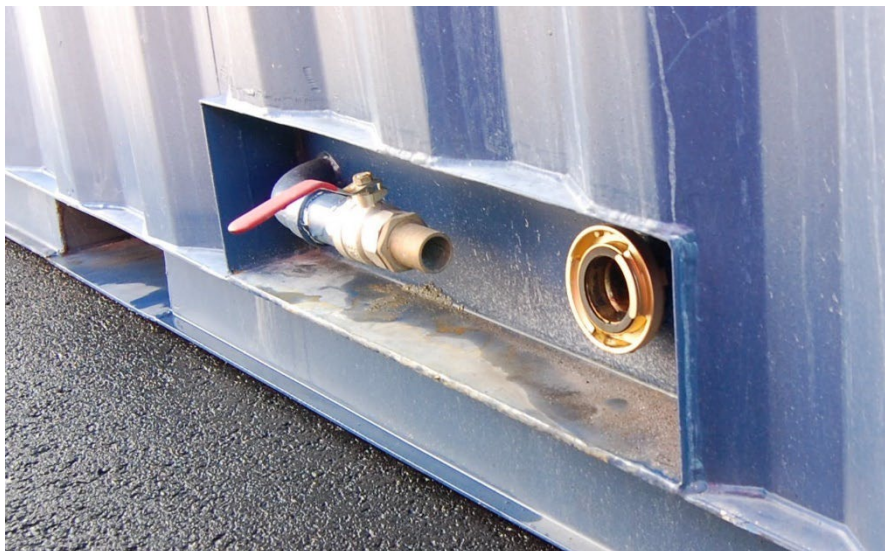
Bild 8 Visar koppling för införing av vatten till höger och tömning till vänster. Källa RSG
